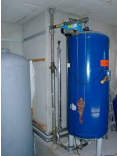
Der Speicher 1 in endgültiger Position. Im Hintergrund ist die hintere Isolierung zu erkennen.
