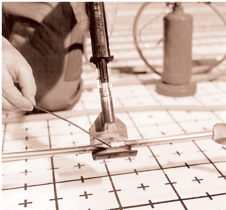
Bild 14: Herstellen einer Hartlötverbindung in einer Kupferrohr-Fußbodenheizung (2657)
