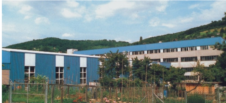
Hauptsitz und Fertigungstätte Pneumatex AG, Füllinsdorf, Schweiz
