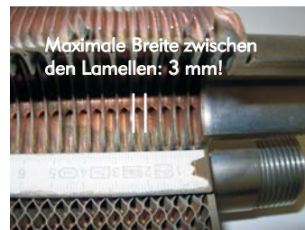
Der Abstand zwischen den Platten ist für die Wärmeübergabe optimal.
