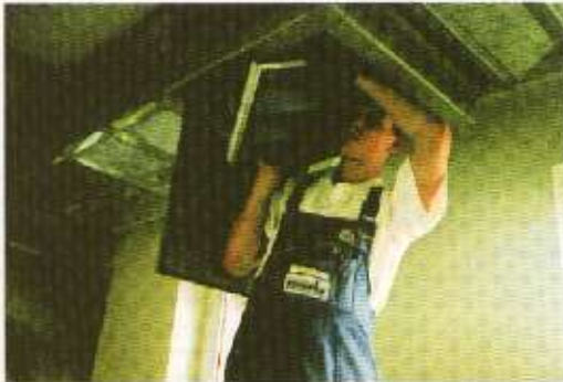
3. Luftfilterreinigung
