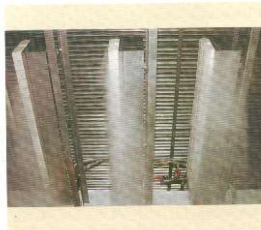
5. Ultraschallbefeuchter
