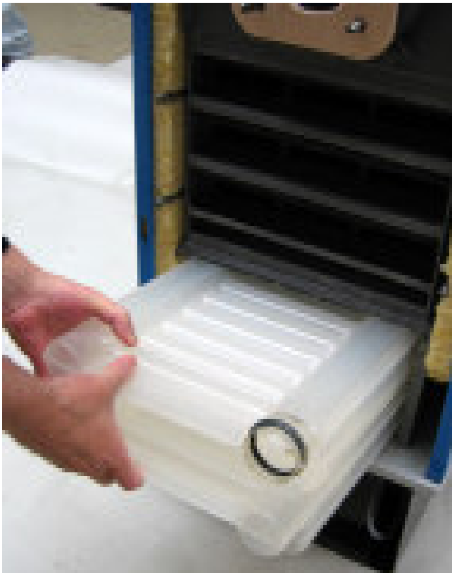
Bild 3-16: Demontage des Kunststoff-Wärmetauschers zur Inspektion/Reinigung.
