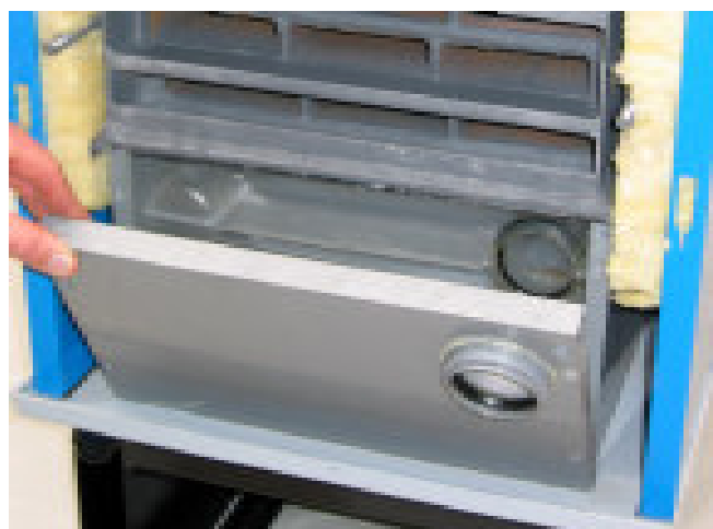
Bild 3-14: Demontage der Stützrahmen-Vorderwand zur Inspektion/Reinigung des Kunststoff-Wärmetauschers.
