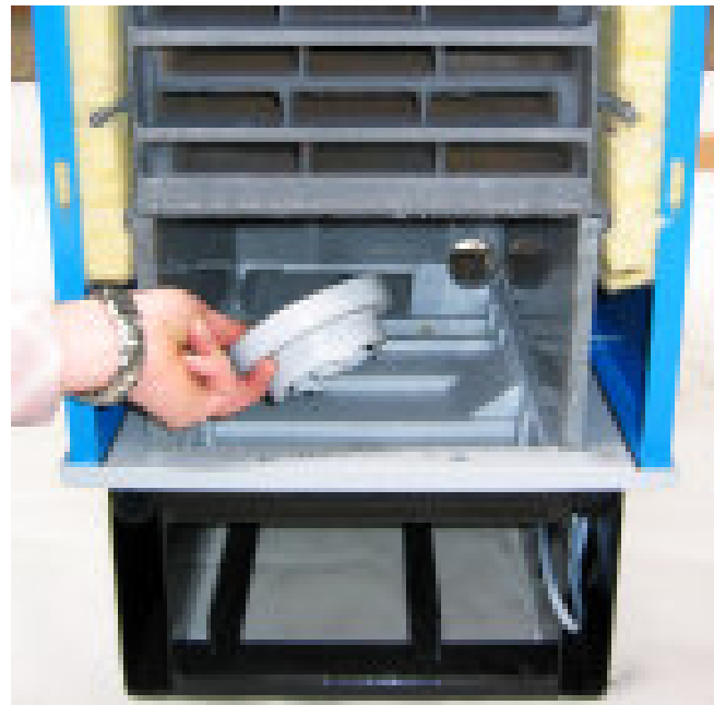
Bild 3-17: Inspektion/Reinigung von Bodenwanne und lose aufgesetztem Geruchsverschluss, nach Demontage des Kunststoff-Wärmetauschers.
