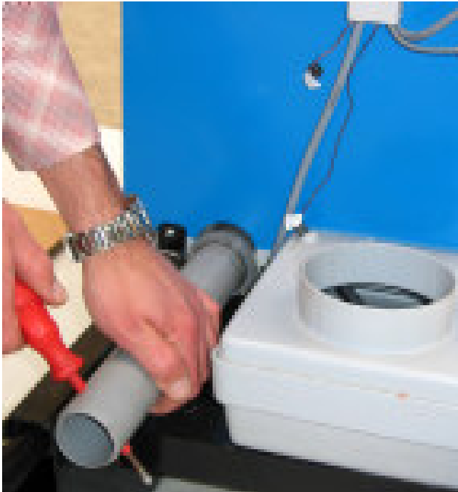
Bild 3-15: Demontage vom hinteren Zuluftrohr.
