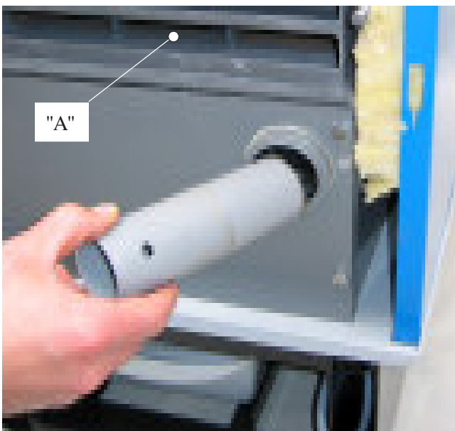
Bild 3-12: Zuluftrohr zur Demontage des Kunststoff-Wärmetauschers herausziehen.
