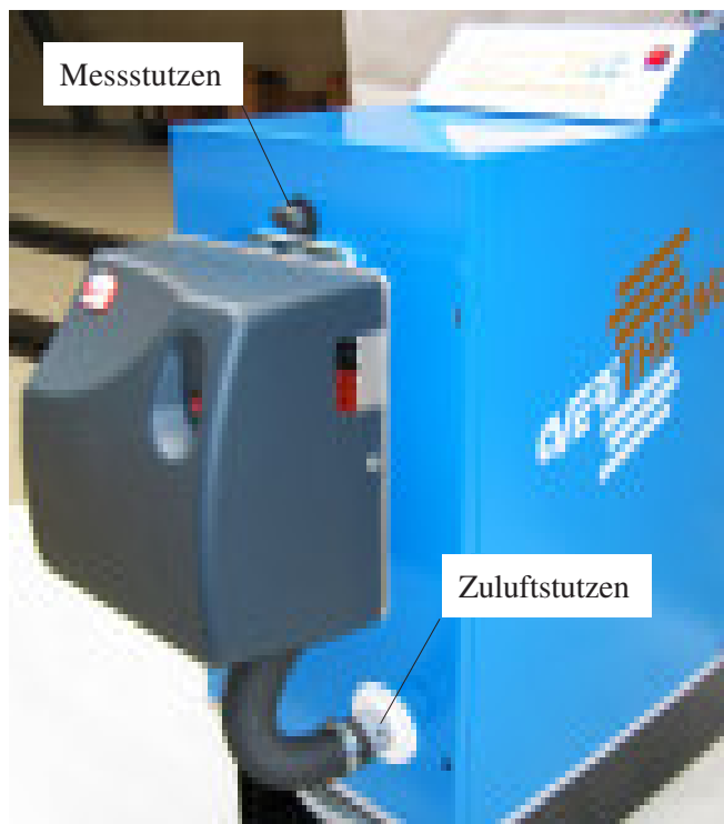
Bild 3-4: Messstutzen, u.a. für CO 2 -, Unterdruck-, NO x -Messungen usw., mit separatem Messgerät und zusätzlicher Messlanze in der Brennkammer sowie Messung der Verbrennungslufttemperatur am Zuluftstutzen.
