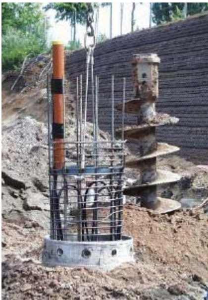
Bild 2-11 Gerüst eines Energiepfahls [34]
