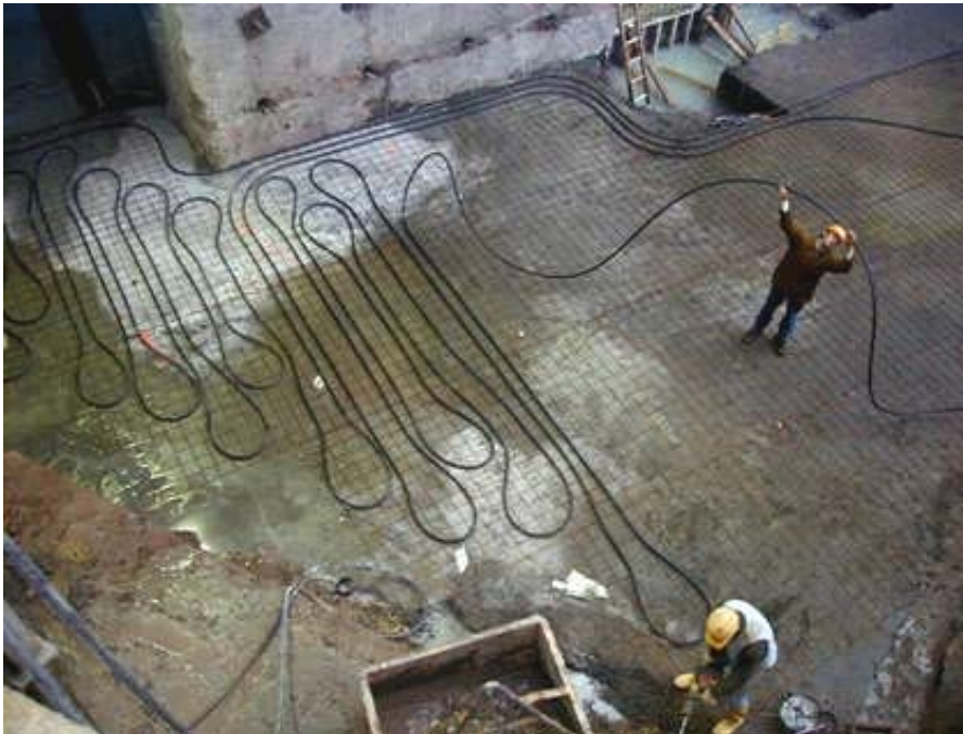
Bild 2-12 Zeigt die Verlegung von Rohrschlangen [34]
