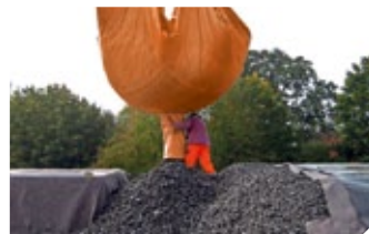
Einbau mit Abladetüchern
