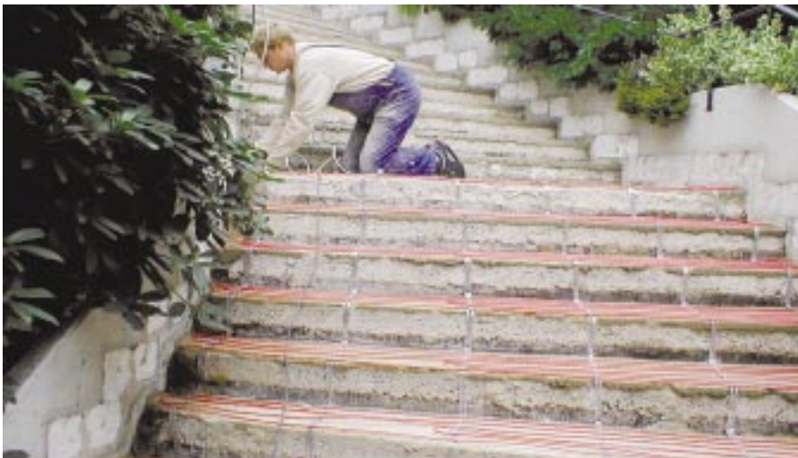
Bild 2.11 Beispiel einer beheizten Treppe
