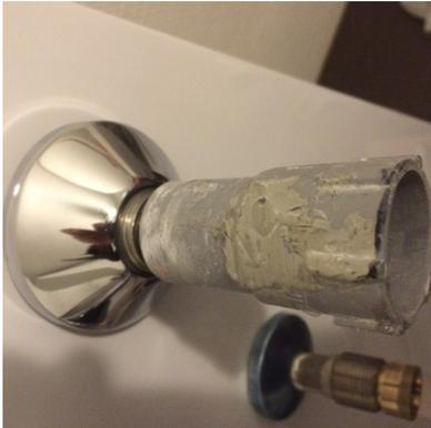
2. Der uni.-S-Anschluss kann bei der Druckprobe mit einbezogen werden.
