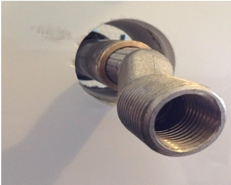
1. Bei Demontage der Armatur lässt sich ein Baustopfen in das Gewinde drehen, so kann die Wasserversorgung in Betrieb bleiben.
