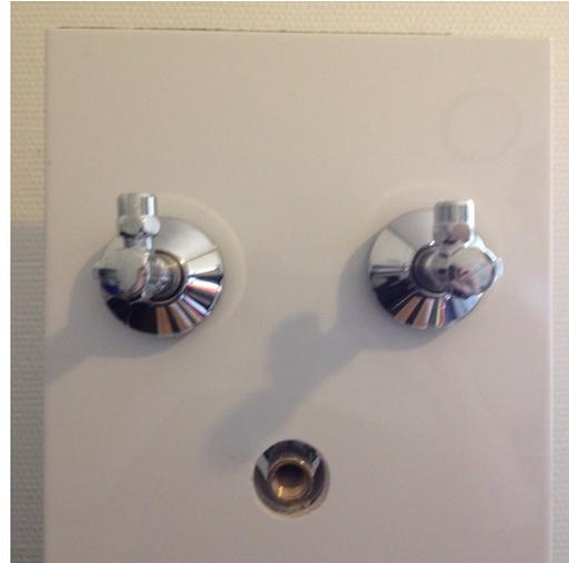
Weitere Vorteile ergeben sich durch das **Innengewinde** im uni.-S-Anschluss !
