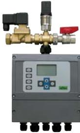
reflex 'magcontrol' kann zwar nicht Entgasen, automatisiert und überwacht aber die Funktion von Membran-Druckausdehnungsgefäßen - eine wichtige Voraussetzung, um das direkte Einziehen von Luft zu verhindern.
