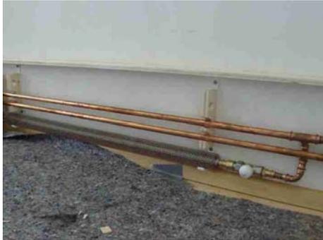
Rohbau - Randleistenheizung mit hohen Montagebügeln,
