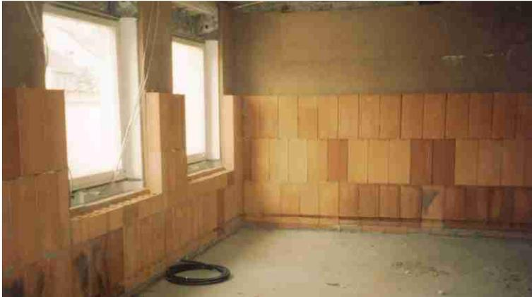
Die Ziegel-Wandheizung wird unter den Fenstern weitergeführt. An den Brüstungen müssen die Ziegel der 2.ten Reihe bauseits so gekürzt werden, daß die Oberkante des oberen U-Ziegels max. der Unterkante Fensterbrett entspricht!
