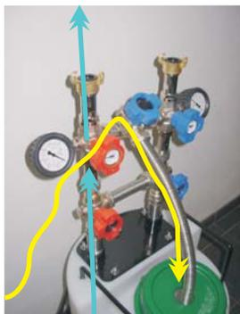
Zufuhr vom Frischwasser oder vorgeschalteten Enthärtungsgerät in den Behälter und von dort aus ins System
