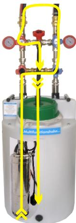
Über den Bypass wird das Medium in den Rücklauf gepumpt. Über den dritten Behälterzulauf kehrt das Medium aus dem System in den Behälter zurück.
