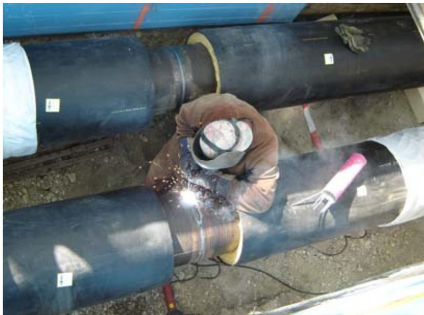
Bild Titelseite: Montage und Verlegung von Fernwärmerohrleitungen. Die entsprechende Normung erfolgt im CEN/TC 107 "Werkmäßig gedämmte Mantelrohrsysteme für Fernwärme", und wird im NHRS gespiegelt durch den Arbeitsausschuss NA 041-01-12 AA "Werkmäßig gedämmte Mantelrohre für Fernwärme"
