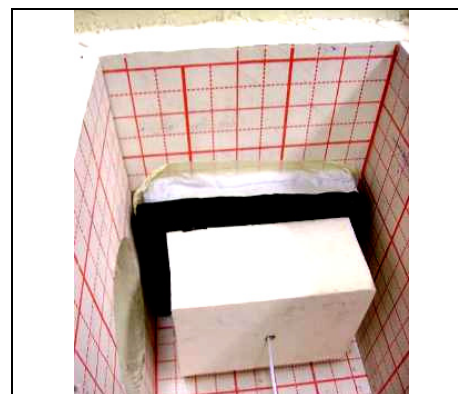
Abbildung 7.23: Rohranfang in der Speicherisolationshülle
