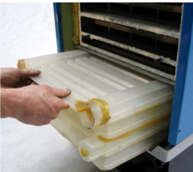
Bild 3-16: Demontage des Kunststoff-Wärmetauschers zur Inspektion/Reinigung.
