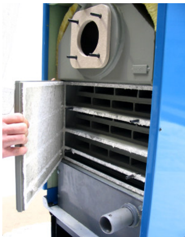
Bild 3-10: Revisionsklappe abnehmen zur Inspektion des Primär-Wärmetauschers.
