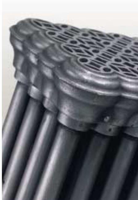
Röhrenheizkörper, der oben mit einem Gitter abschließt, Washington um 1870.
