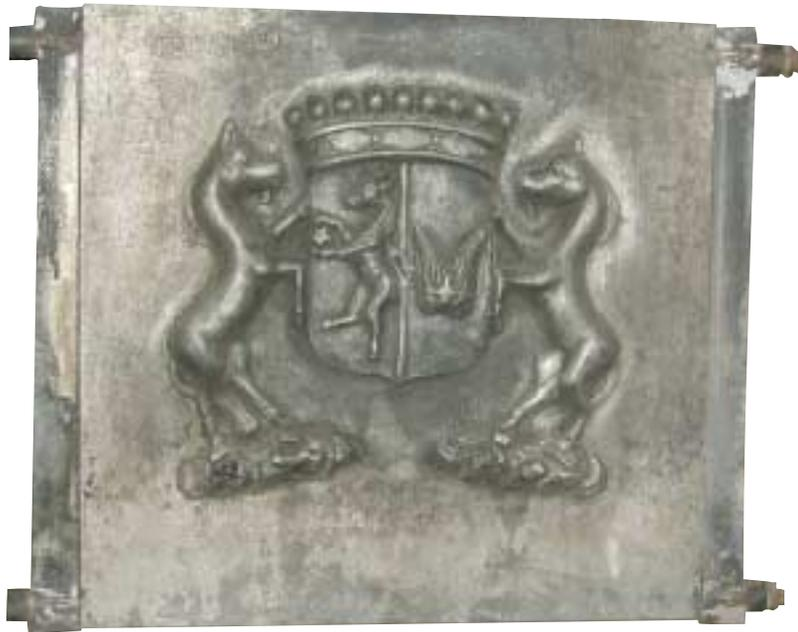
Flacher Plattenheizkörper, ausgestellt bei der Firma Andera in Maastricht.
