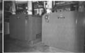
Die 2 Erdgaskondensatessel mit je 400 kW in Verbindung mit einem 100 kW BHKW.
