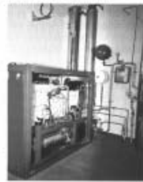
Die 2 Erdgaskondensatessel mit je 400 kW in Verbindung mit einem 100 kW BHKW.
